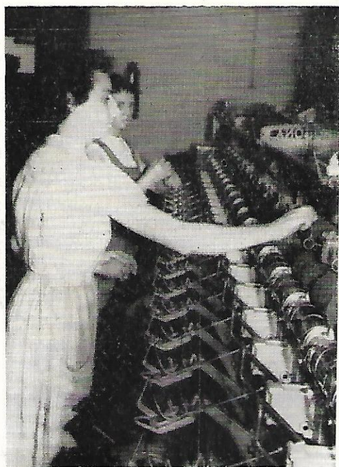
As máquinas "Leesona" são as unidades de maior rendimento na bobinagem. Na gravura vê-se uma encruzadeira dessa marca, que enrola o fio de urdimento em bobinas cruzadas
